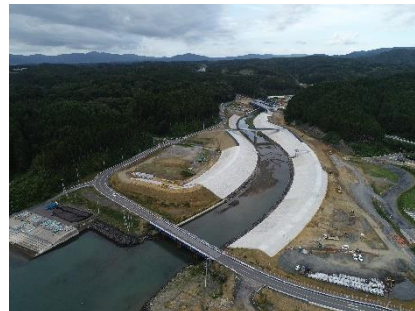
青木あすなろ建設 伊里前川河川災害復旧工事(その2)
