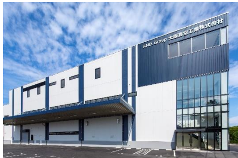
青木あすなろ建設 (仮称)大阪真空工業(株)星田工場新築工事
