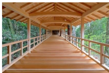
金剛組 丹生川上神社下社境内整備及び階(きざはし)改築工事
