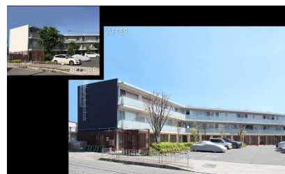
高松テクノサービス(大阪) RC造3階建て 賃貸マンション外壁リフレッシュ工事
