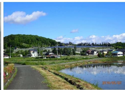
東興ジオテック 東北自動車道 栃木都賀JCT~鹿沼IC間 のり面補修工事
