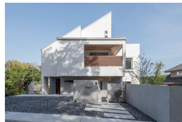
タツミプランニング 施工物件
