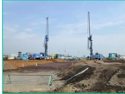
羽田空港跡地基盤整備工事 （地盤改良工事）
