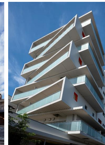
高松建設 大阪 吹田・マンション
