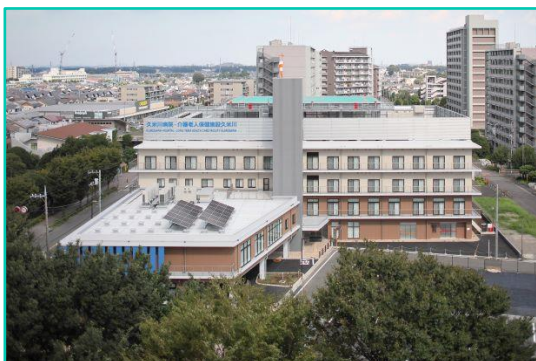
（仮称）介護老人保健施設久米川新築工事
