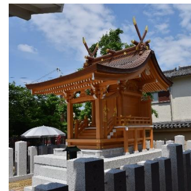
金剛組 (大阪市天王寺区) 四天王寺用明殿新築工事
