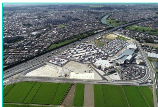
東北自動車道蓮田サービスエリア（新上り線）工事
