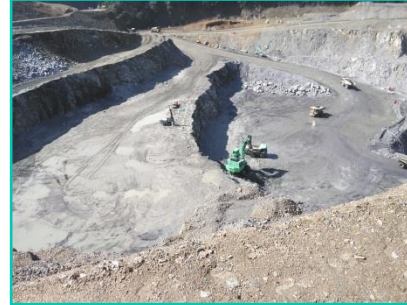
小石原川ダム工事 （爆砕工事）
