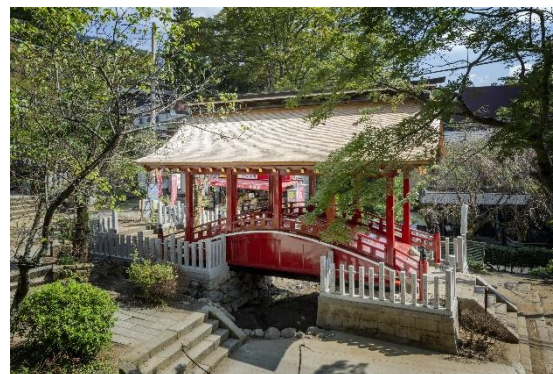
金剛組 (茨城県つくば市) 茨城県指定文化財筑波山神社神橋(しんきょう)修理工事
