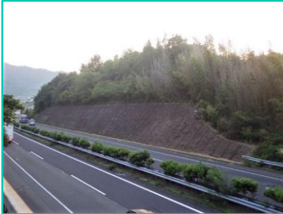
香川高速道路のり面補修工事 （法面保護工事）
