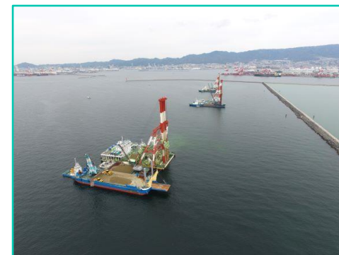
神戸港航路付帯施設地盤改良工事
